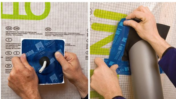
**13. Anschluss an Kabel und Rohre**
