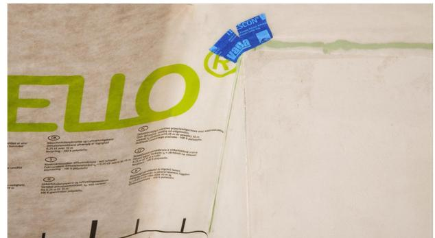
**12b. Anschluss an verputzten Schornstein (gedämmt oder 2-schalig)**
