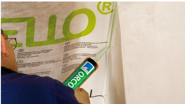
**12a. Anschluss an verputzten Schornstein (gedämmt oder 2-schalig)**
