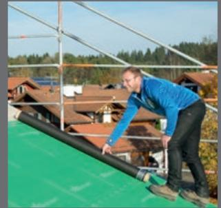
Bahnen und Zubehör für die Abdichtung der Gebäudehülle runden das STEICO Bausystem ab und gewährleisten bauphysikalisch richtungsweisende Konstruktionen.
